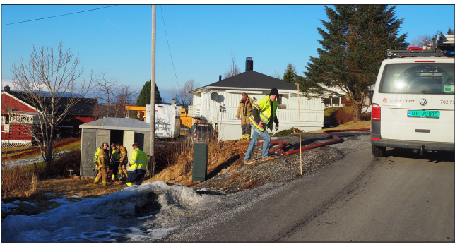
KONTROLL: Mannskap fra brannvesenet og Nordvest Nett på plass ved trafostasjonen. FOTO: OLAV SKJEGSTAD
